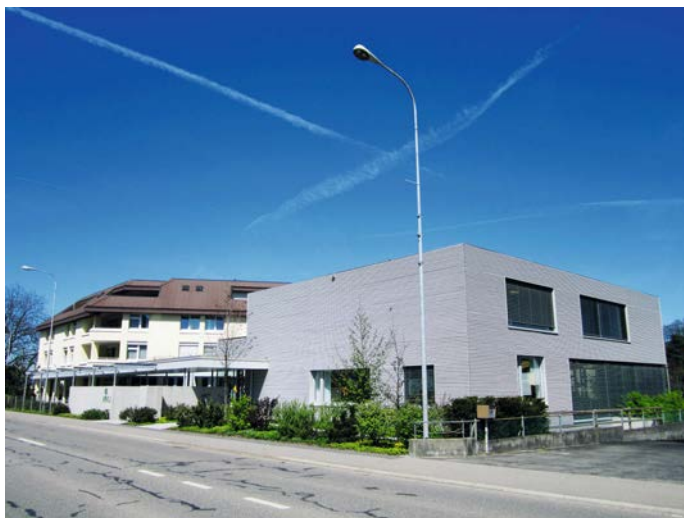
Anbau des Behinderten-Wohnheims «Höfli», Wangen
